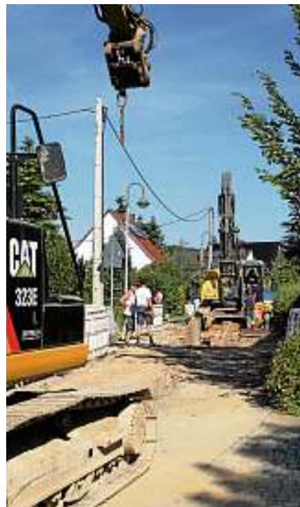
Bis 31. August laufen von der Sprottebrücke aus die Arbeiten.
