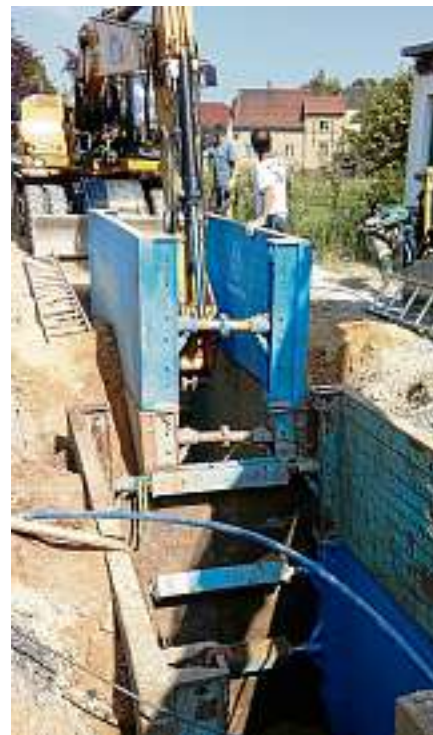
In 5,50 Meter Tiefe werden die neuen Versorgungskanäle verlegt. Foto: Uwe Glück
