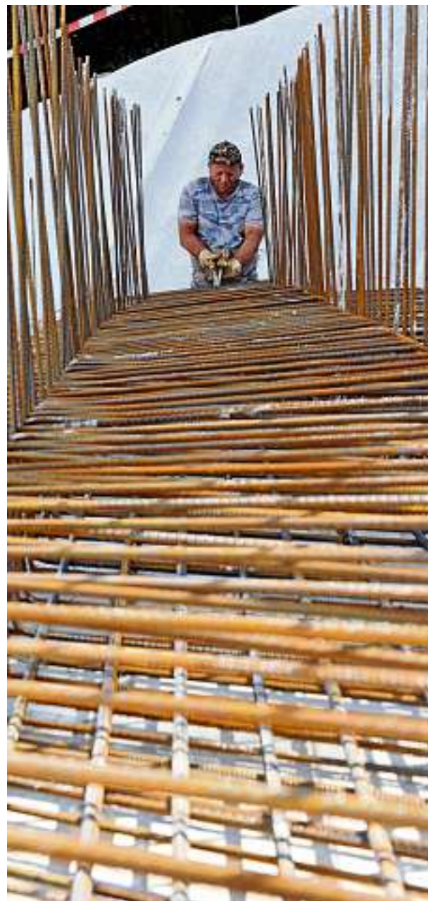
Derzeit wird zwischen Lindenkreuz und Waltersdorf auf der Kreisstraße 129 eine neue Brücke gebaut. Die Tiefbauarbeiten sind aktuell in vollem Gange. Eisenflechter bereiten die Gründungen vor (Bild rechts). Planerin Andrea Prendel vom Ingenieurbüro Härtling in Lehnendorf bespricht mit Eisenflechter Idris Idrisi die weiteren Arbeiten (Bild links). Fotos: Peter Michaelis
