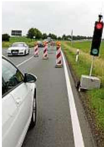
Auf der B 92 bei Wittchendorf wurden Straßenschäden beseitigt. Foto: Katja Grieser
