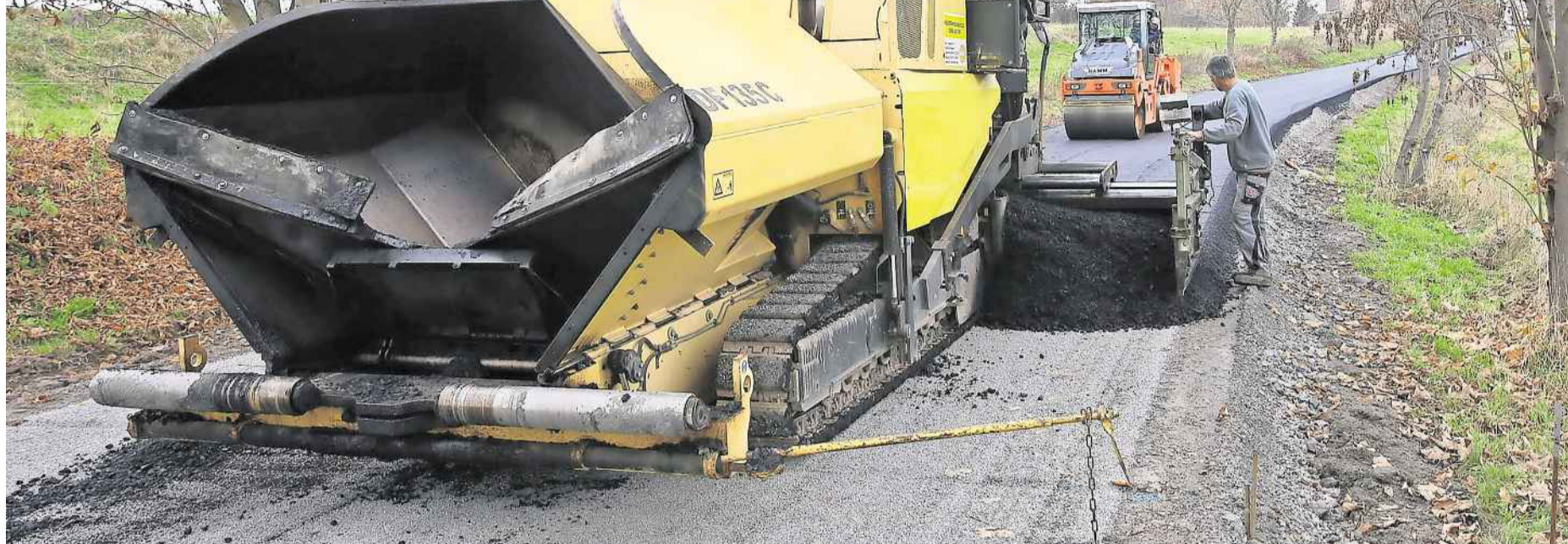
Früher als geplant haben zwischen Windschleuba und Remsa die Arbeiten zum Aufbringen der Trag- und Deckschicht begonnen.
