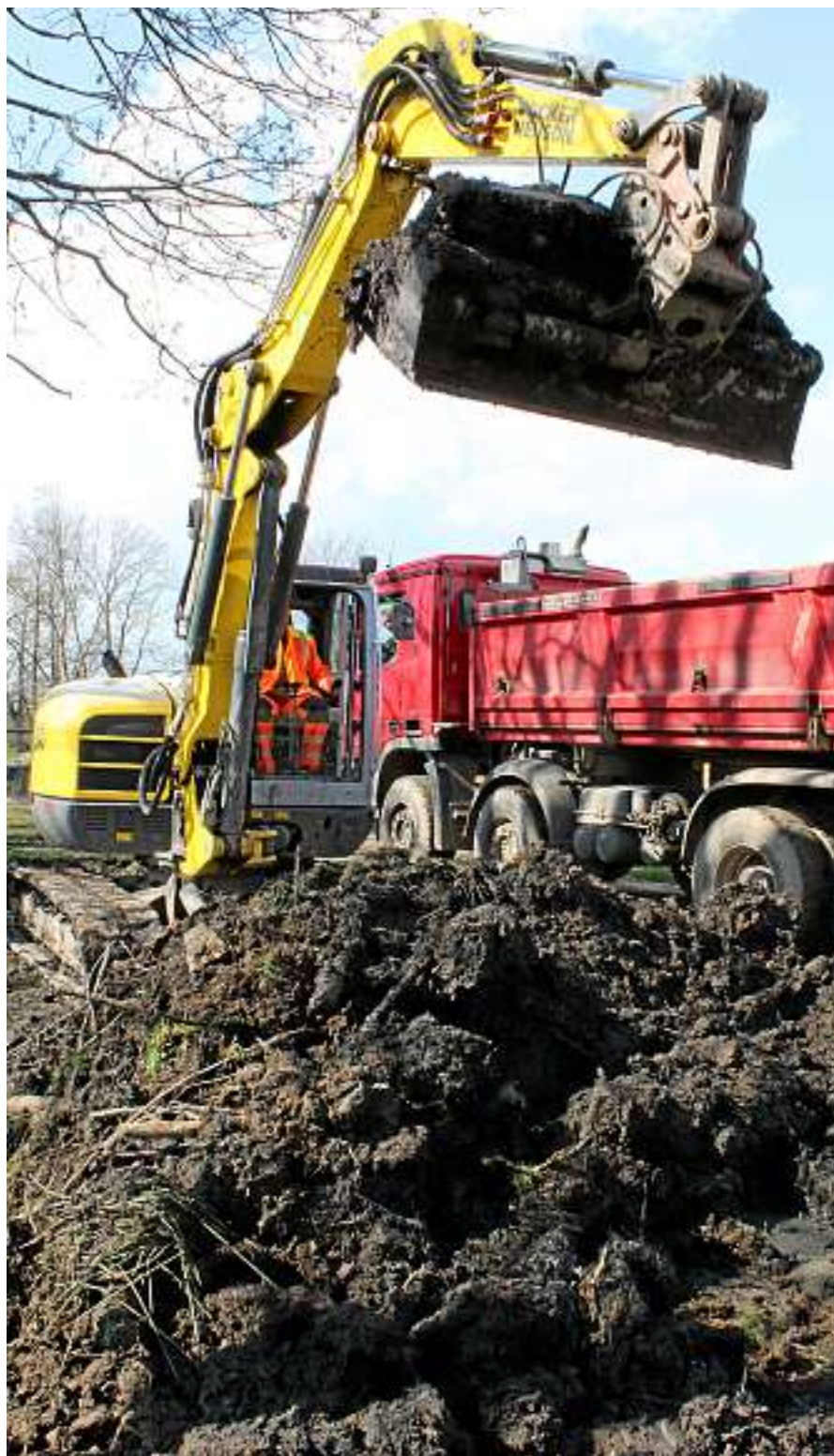
Jede Menge Schlamm haben die Arbeiter aus dem Mühlgraben gebaggert. Der muss auch noch verladen, abtransportiert und entsorgt werden.
