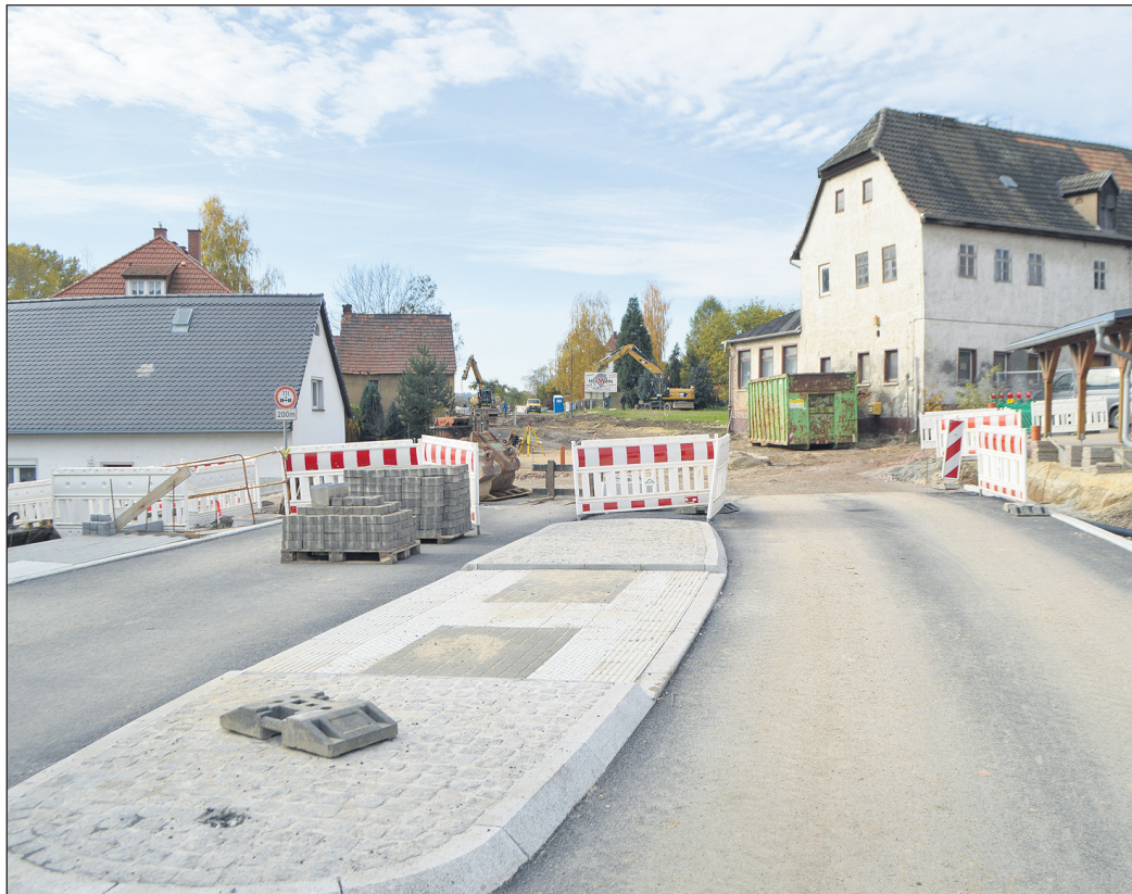
Vor dem Abzweig Lohma endet in der Ortslage Untschen der fertiggestellte Straßenbereich.
