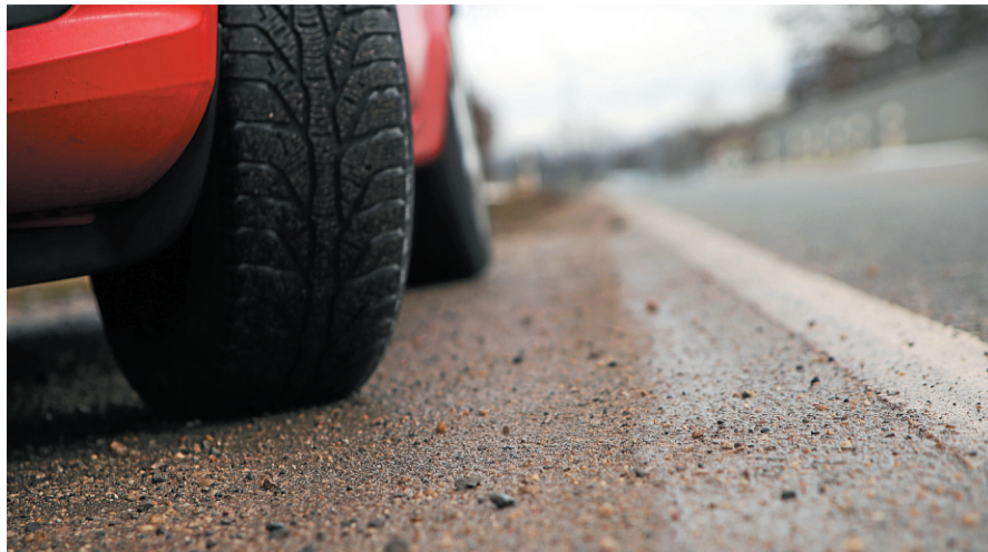
Die Bankette der viel befahrenen Straße Zum Wasserturm werden beidseitig erneuert. Das ist auch für die Strecke Schönhaide – Selka vorgesehen. FOTO: JANA BORATH
