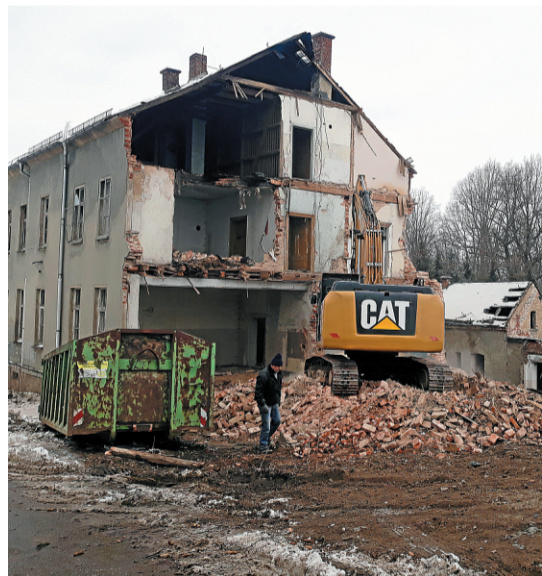
Die alte Schule in Grünberg wird seit dieser Woche abgerissen. FOTO: MARCEL GREUNKE
