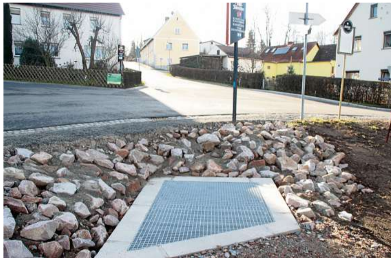
Der neu geschaffene Regenwasser-Einlauf an der Kreuzung Dorfstraße/Am Schulberg/Am Hofgarten.
