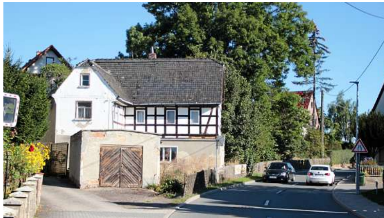
Eine Engstelle soll verschwinden: Dieses Haus, in der Schmöllner Straße 35 in Altkirchen, ist einsturzgefährdet. Die Stadt hat das Grundstück mittlerweile erworben, um das Gebäude abzureißen. Doch noch wartet man auf die Genehmigung durch das TLBV.
