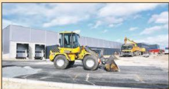
Neu errichtete Hallen auf dem fertiggestellten Teilgebiet V.
