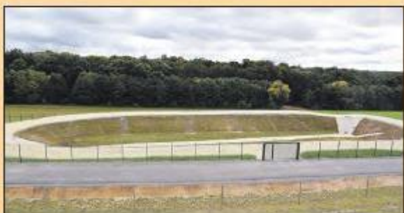
2.750 Kubikmeter Speichervolumen besitzt das neue Regenrückhaltebecken.
