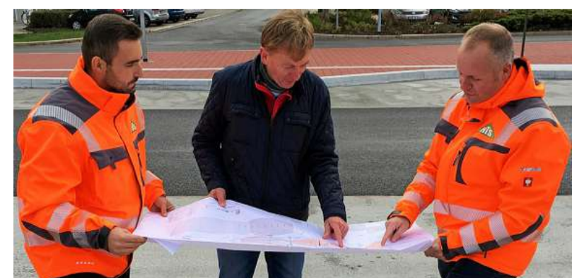
Uwe Glück vom städtischen Bauamt (Mitte) im Gespräch mit den Bauleitern Michael Trömel (r.) und Eugen Plotnikov. FOTO: JANA BORATH
