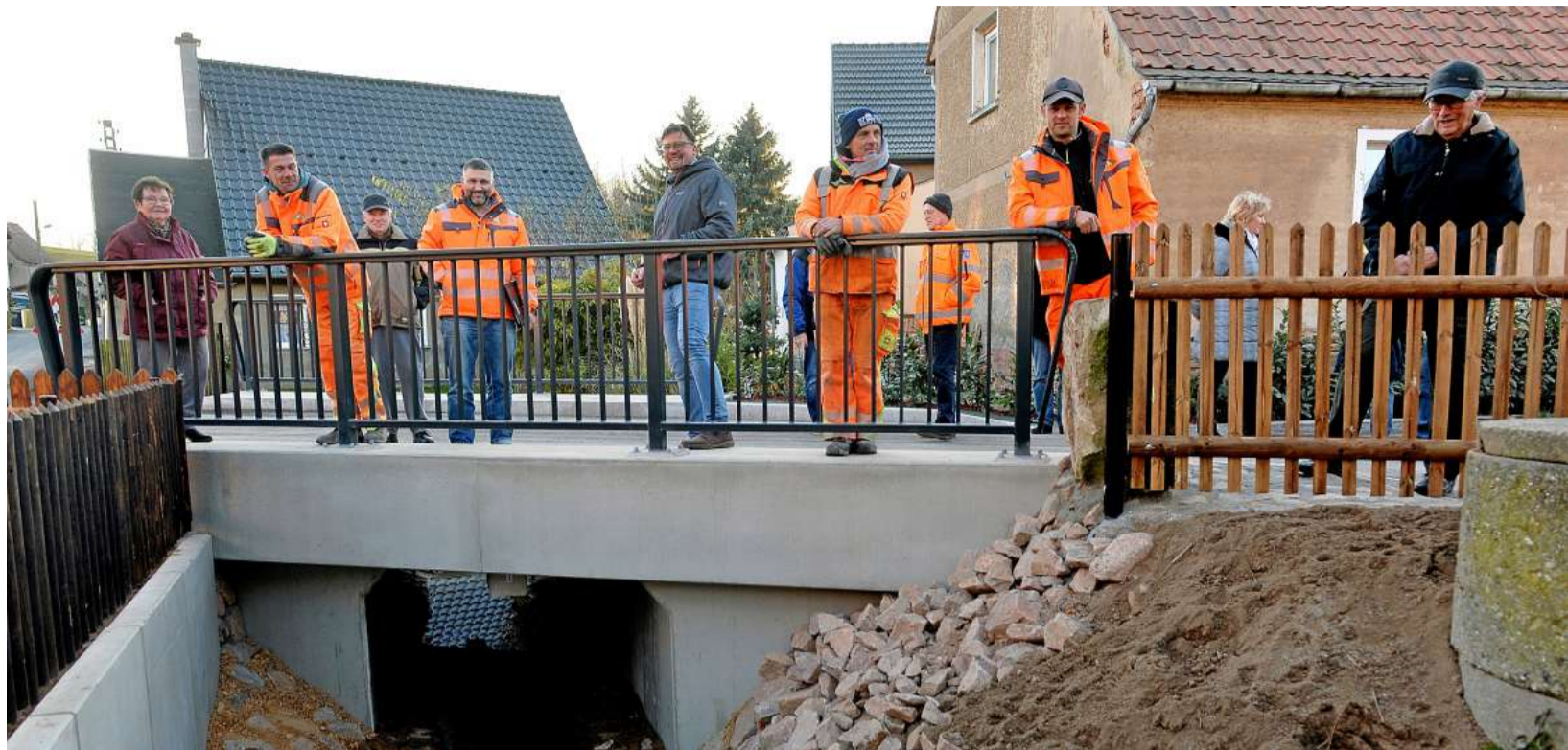
Nach langem Anlauf konnte nun die neue Brücke Am Fichtenberg in Reichstädt mit größerem Durchlass nach dreimonatiger Bauzeit eingeweiht werden.
